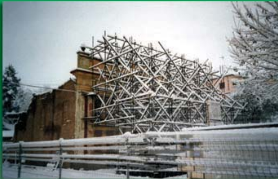
CIANO D'ENZA (RE) RISTRUTTURAZIONE E CONSOLIDAMENTO STRUTTURALE EX TEATRO
