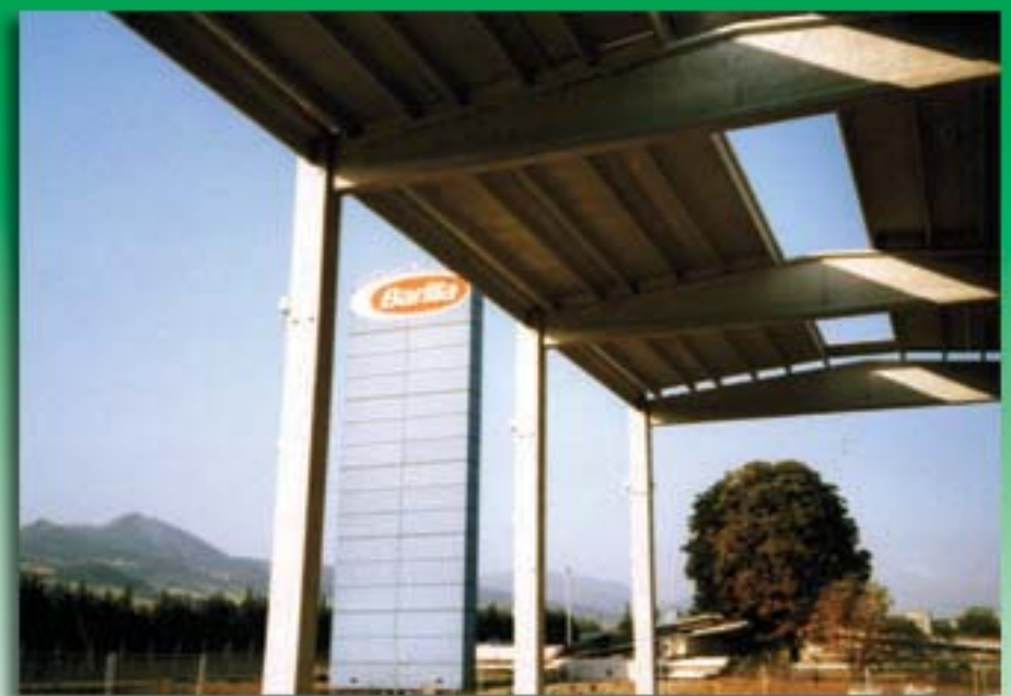
PARMA LAVORI DI AMPLIAMENTO STABILIMENTO BARILLA
