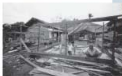
Le prime fasi dei lavori di ricostruzione
