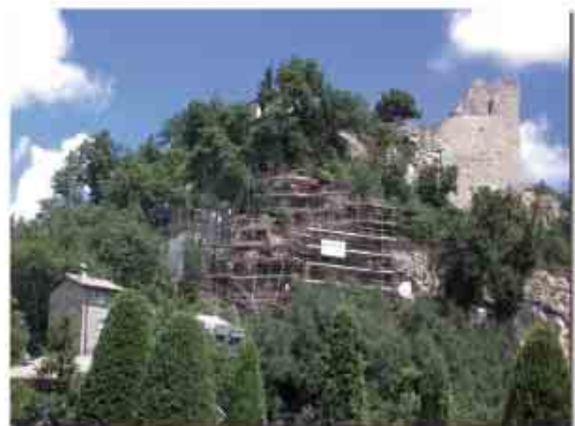
Consolidamento Rupe di Canossa - anno 2002
