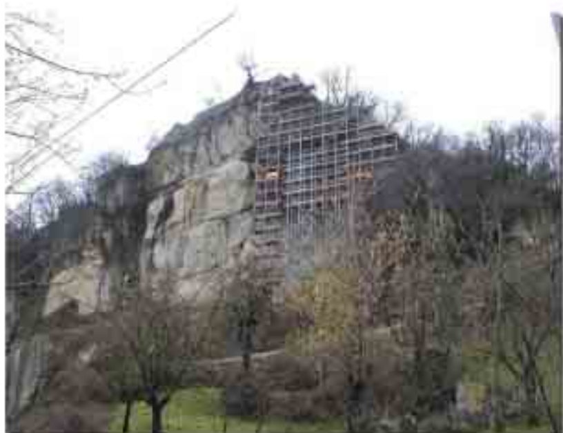
Consolidamento Rupe di Canossa - anno 2000
